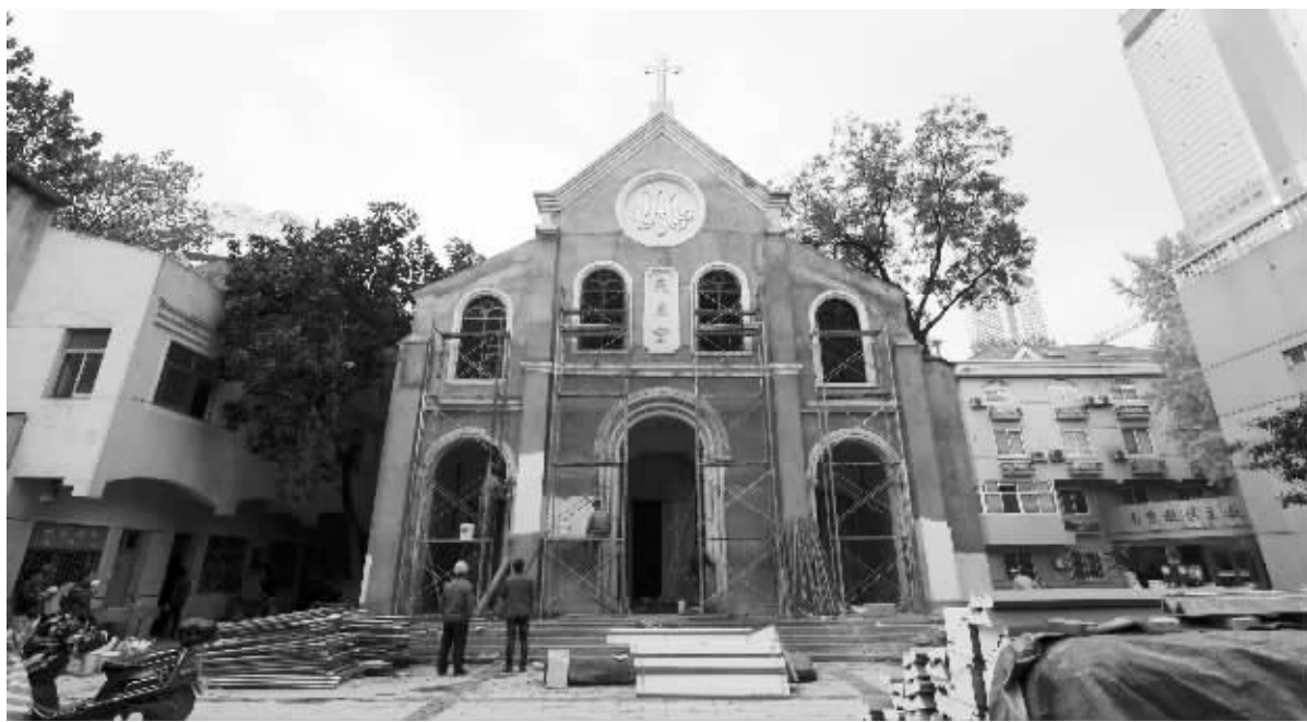
位于石鼓路的天主堂正在进行维修
