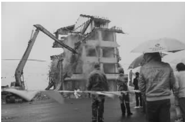
12月1日,浙江温岭“最牛钉子户”房屋拆除现场
