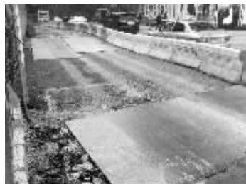
路面被填平后,盖上了钢板 现代快报记者 贾磊 摄
