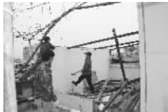
工作人员正在拆除楼顶上的违建 现代快报记者 仲茜 摄
