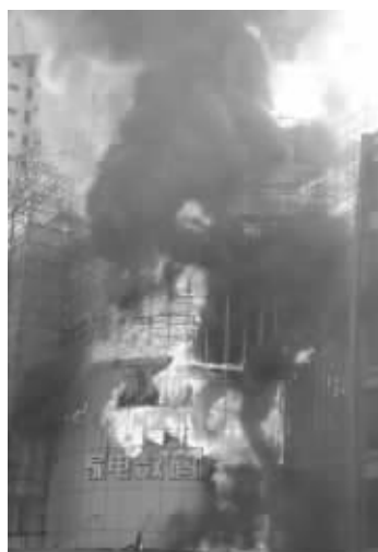
昆山正阳桥附近一商业楼发生火灾 图片来自网络
