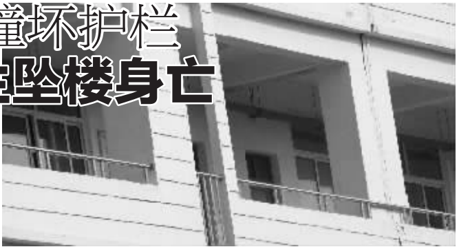
教学楼内的不锈钢栏杆
