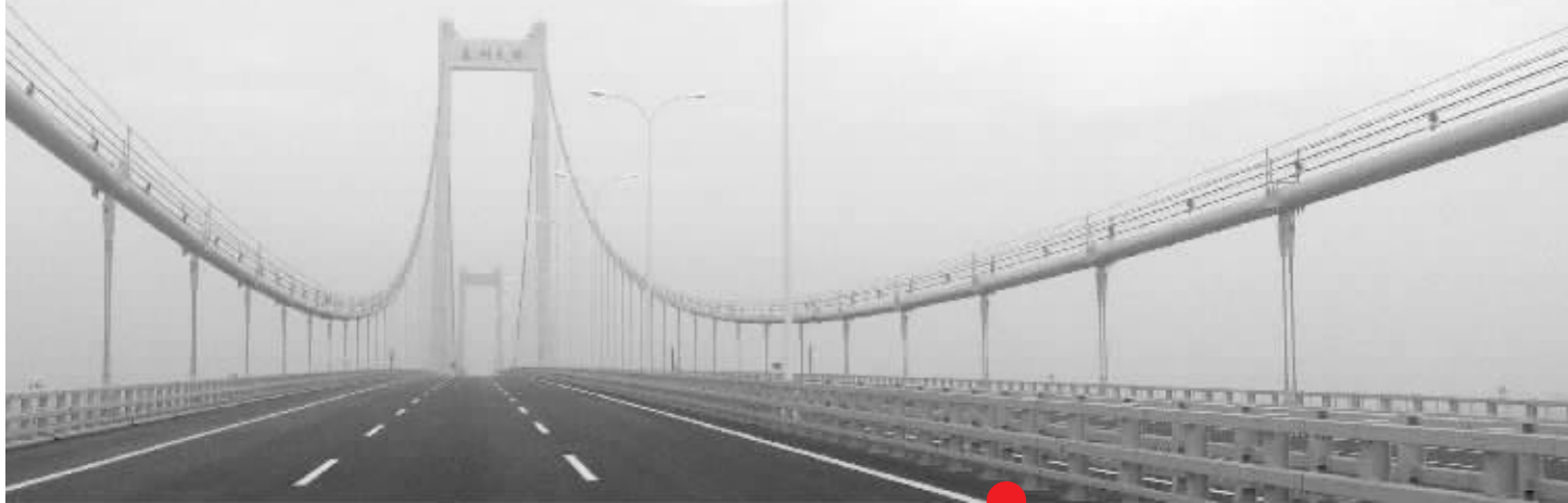
宽敞整洁的泰州大桥 现代快报记者 姚斌 摄
