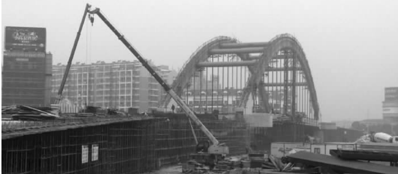
大桥主体已基本完工,工人们仍在紧张施工
