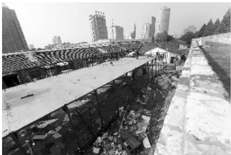
城墙下的违建和垃圾堆很煞风景 现代快报记者 赵杰 摄
