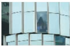
**紫峰大厦第1次“玻璃雨”：**2011年12月26日晚上10点多，紫峰大厦幕墙6楼处，一块玻璃发生碎裂，当时爆裂的玻璃长约2米，宽约1米，竖立安装在大厦主楼6层外墙的弧面上。爆裂的是中空的双层玻璃的外层，大部分玻璃碎片都已掉落，形成一个三角形的空洞。当时紫峰大厦工程部确定发生碎片坠落的那块玻璃是自爆，具体原因可能跟天气较冷或是玻璃质量本身有关。因为当时的事情发生在晚上，没有人员从楼下经过。
