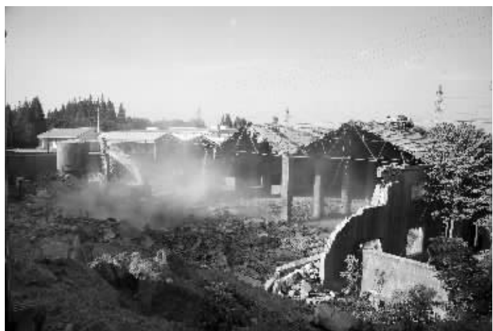
“违建村”最后一排铁皮板房昨天拆除
