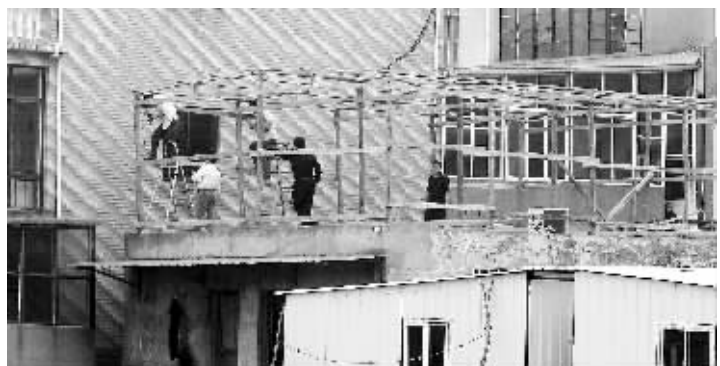
村民们先撑好木架,再加上铁皮屋顶,一天能盖一层
