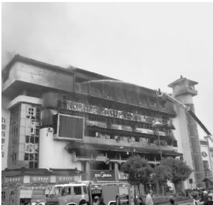
上午9点多钟,消防车仍在现场喷水 通讯员供图
