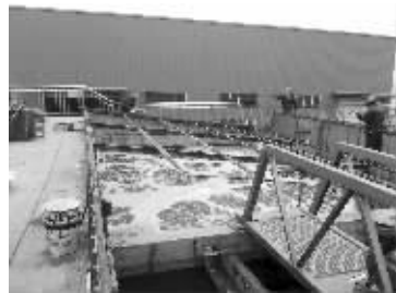
工人正在生化池上施工准备加盖
