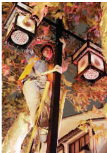
工人正在更换路灯 陈钟靓 供图
