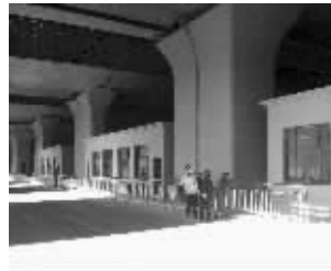
刚刚建成的三幢公交站房 现代快报记者 鲍铭东 摄
