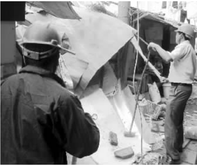
施工人员正在拆违 通讯员供图
