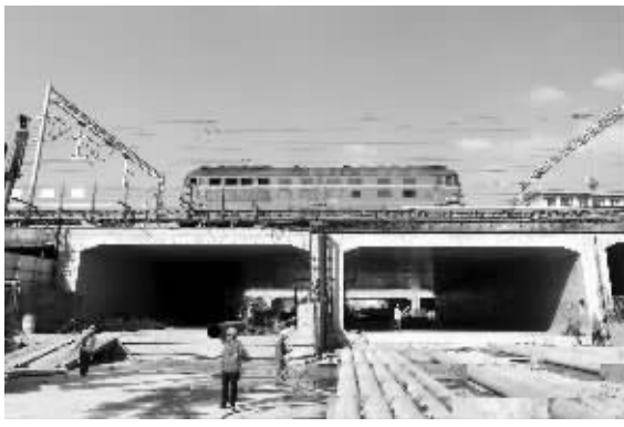
新箱涵已经换上 现代快报记者 赵杰 摄
