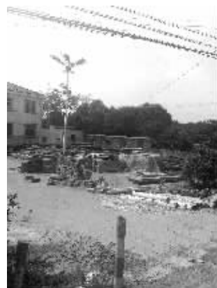
村民自建房现场
