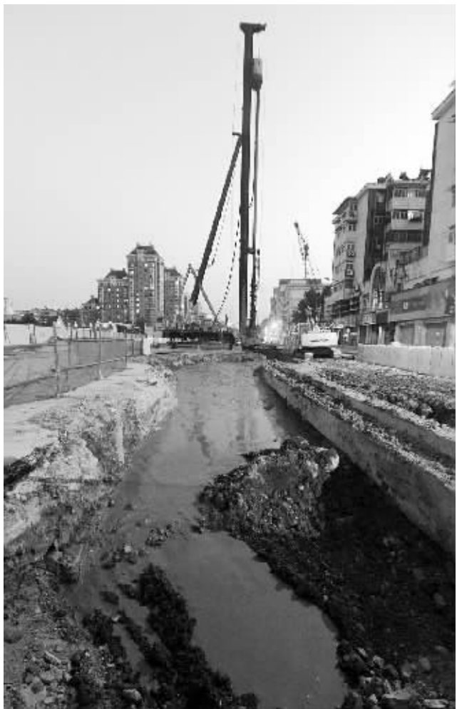
城西干道隧道率先开挖的水西门段起点位于罗廊巷口,因为是隧道的敞开段,所以挖得并不深 现代快报记者 赵杰 摄
