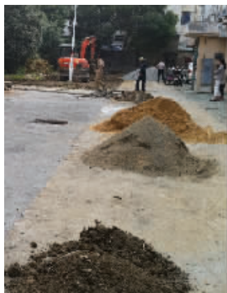
挖掉的绿化带已经铺上水泥,远处,挖掘机还在施工
