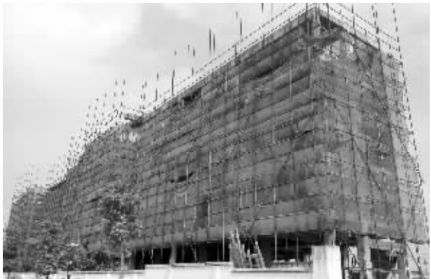
六合的这幢烂尾楼将面临拆除的命运
