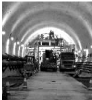
盾构机正在掘进施工 现代快报记者 顾炜 摄
