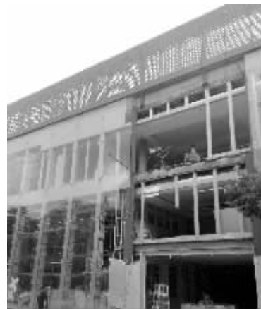
C5幢西侧在建的门厅，部分属于违建
