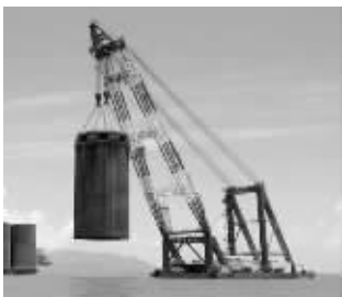
港珠澳大桥在建造人工岛
