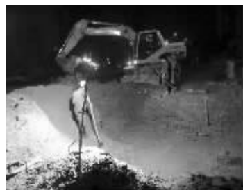
施工人员正在抢修
