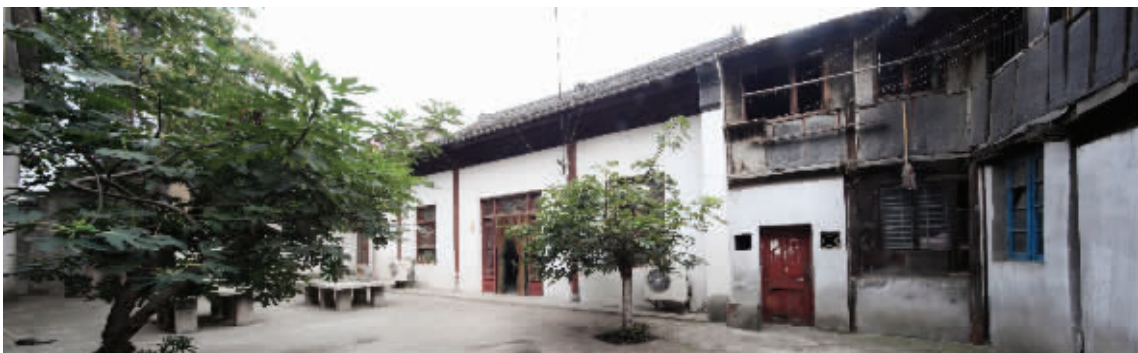
位于学校内的清代古建筑
