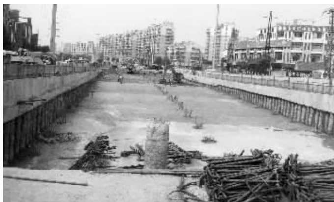
纬一路中央北路隧道开挖,隧道口开敞段雏形已现
