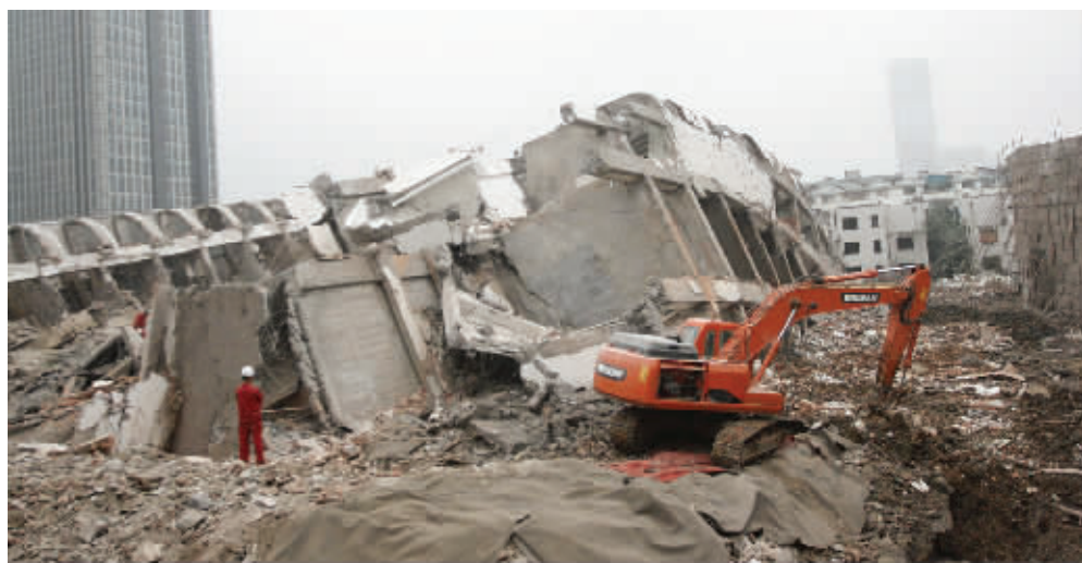
爆破现场 汤米/摄
