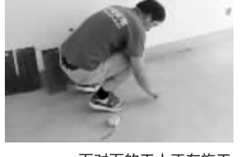
面对面的工人正在施工
