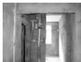
爱华装饰施工现场
