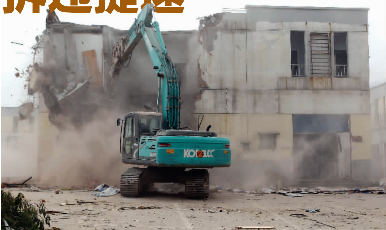
昨天, 南京玄武区城管局组织了200多人、20台挖掘机集中拆违 现代快报记者 李雨泽 摄
