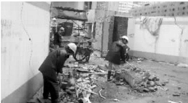
昨天早上,施工人员在现场进行清理 通讯员供图
