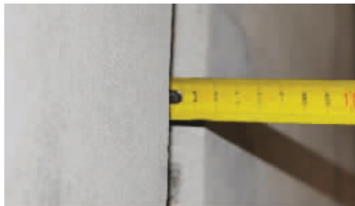
16毫米、20毫米管深度不少于31毫米、35毫米
