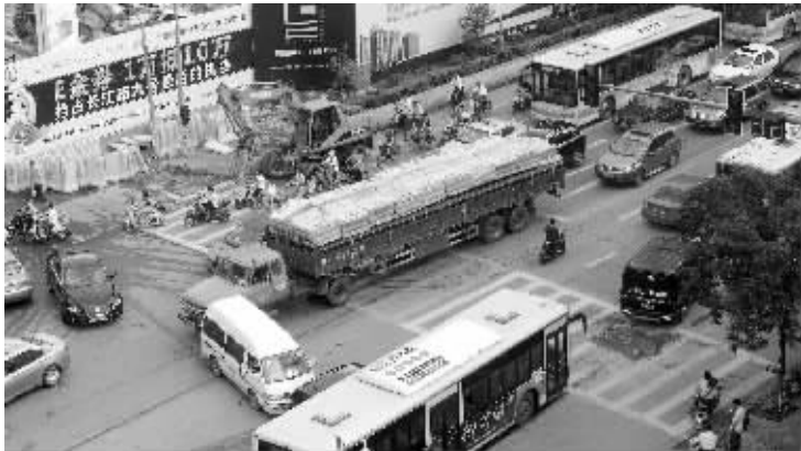
昨天,施工设备进场,洪武北路交通大受影响 现代快报记者 赵杰 摄
