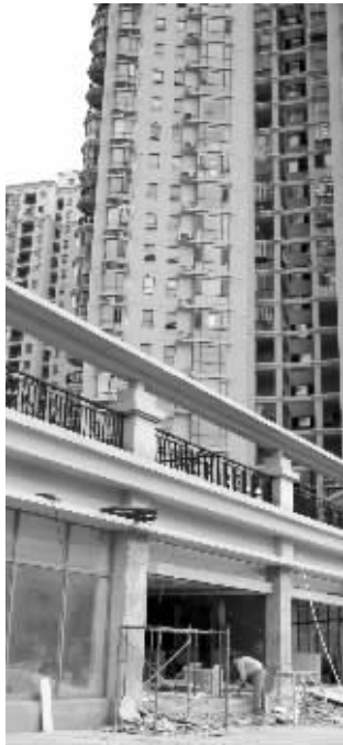
正在装修的医院 现代快报记者 李雨泽 摄
