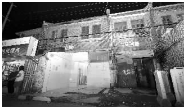
青石街上的青松饭店违建部分已拆掉 现代快报记者 赵杰 摄
