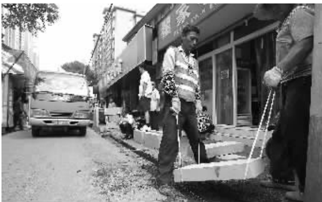
工人们正在忙着修整路面 现代快报记者 辛一 摄
