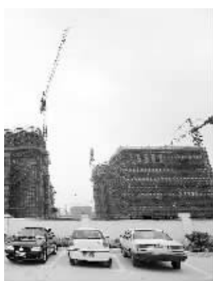
青奥村施工现场,运动员公寓已经封顶
