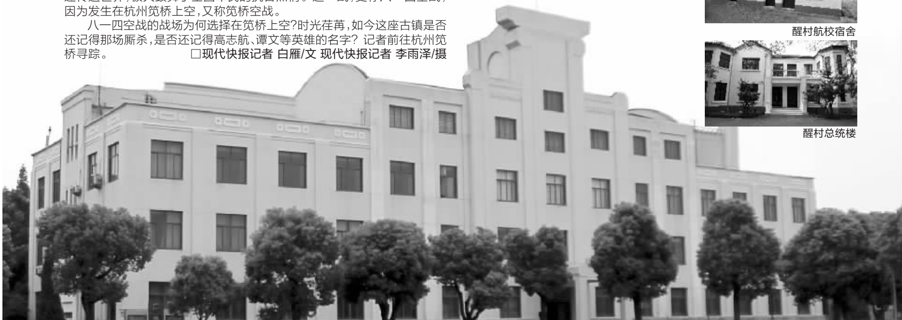
原国民党中央航校办公大楼
