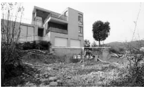
某地一别墅业主,挖地3米多深,私建游泳池(资料图片)
