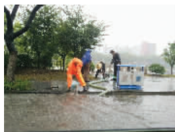
运河东路正在抽路面积水
