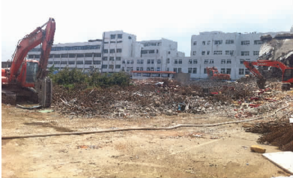
常州田家炳中学新校区,上世纪80年代建的楼几乎全被拆掉了 李梦雅 摄
