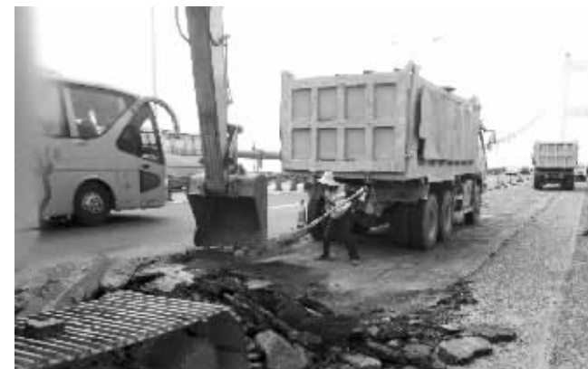
桥面上已开始施工 胡姍姍 摄
