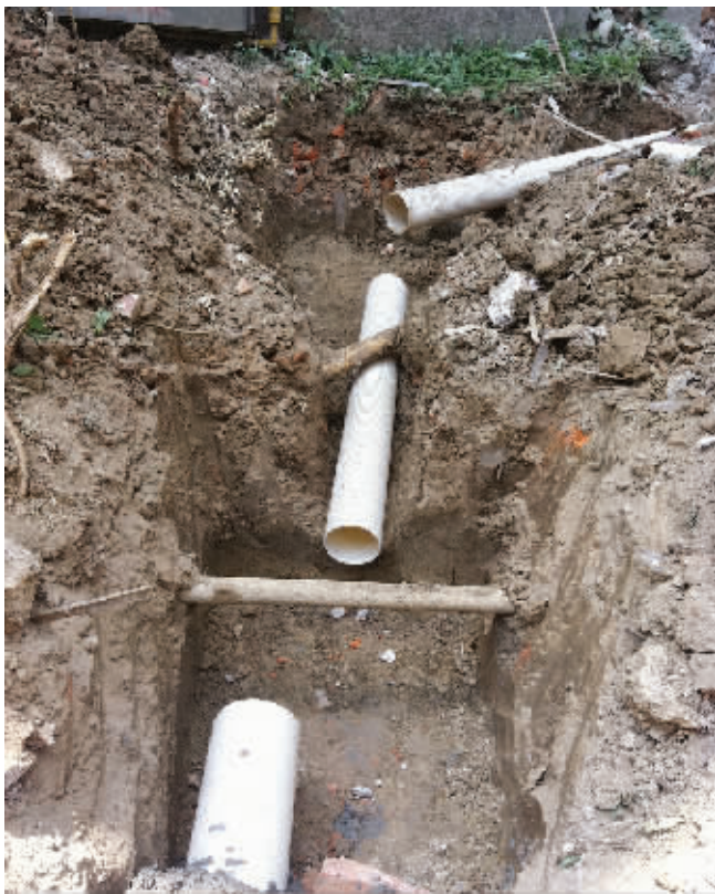
据房管局工作人员介绍,塑料波纹管做雨水管比水泥管有优势
