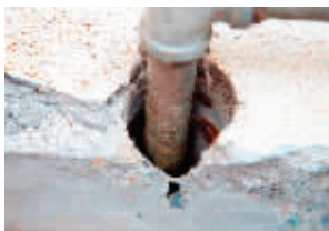
被水钻孔截断的钢筋
