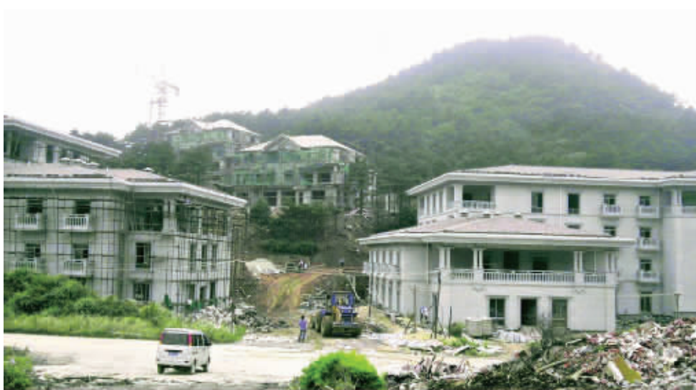
记者在施工现场看到,一期项目已经施工完毕
