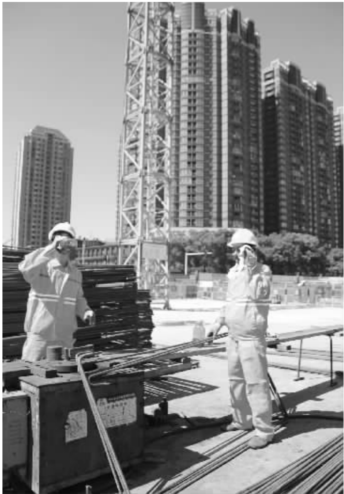
身着工作服、头戴安全帽的地铁建设工人冒高温作业
