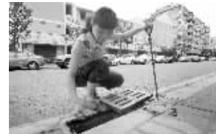
陈平正在检查排水管道 现代快报记者 施向辉 摄
