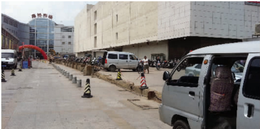
7月6日,金桥市场和鑫桥市场之间的围墙被拆除
