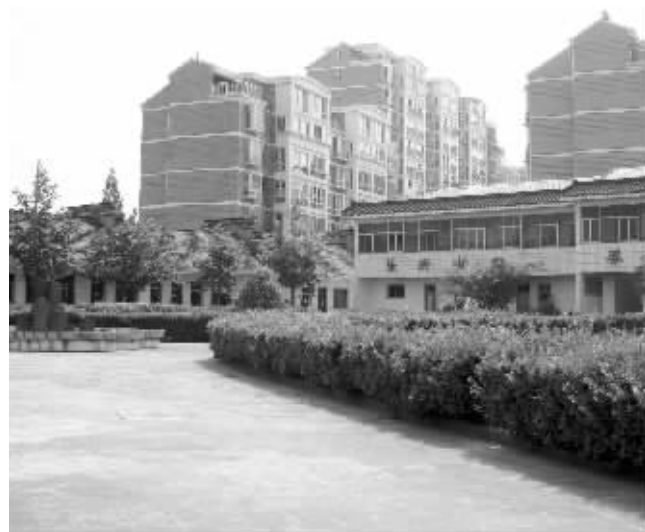
旧的养老院一下雨就漏,正准备维修
