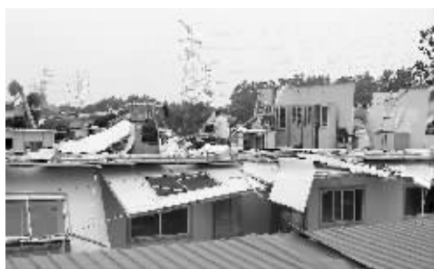
不少板房的房顶被掀
